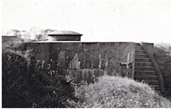
Een hefkoepelgebouw van Fort bij Aalsmeer. De koepel staat in de bovenste stand en de kanonsloop is uitgeschoven. (NL-WpDStvA C3775, 1940-1942)
