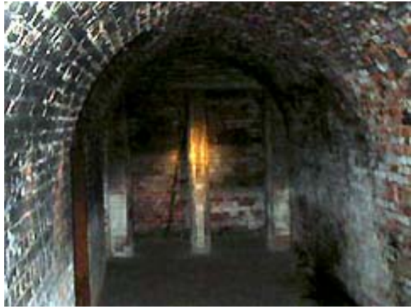
Toiletten. (Ron Erhardt)
