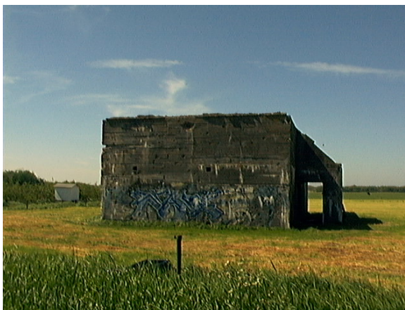
De Vlijt bunker zijkant (René Ros)
