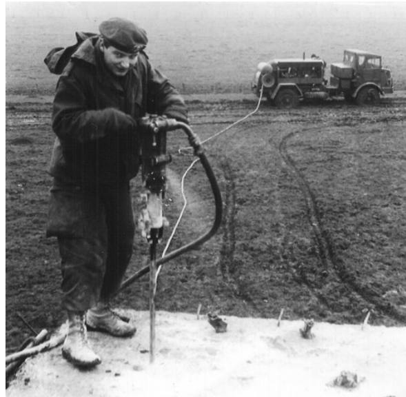
Gaten boren voor de explosieven. (Wim Kiele, 1968)
