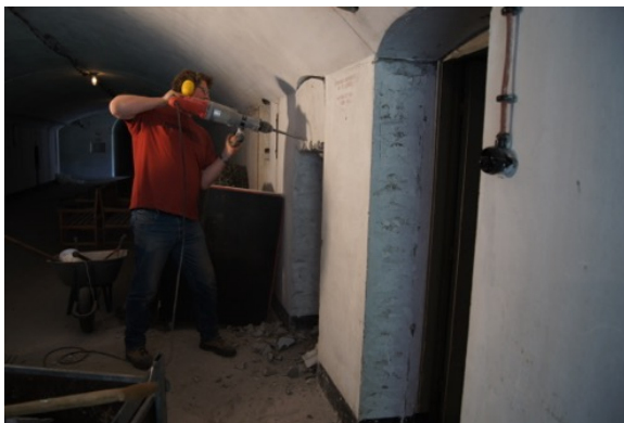
René Ros breekt met een sloophamer een van de dichtgemetselde deuropeningen in Fort bij Uithoorn uit. (Hans Baas, 2013)
